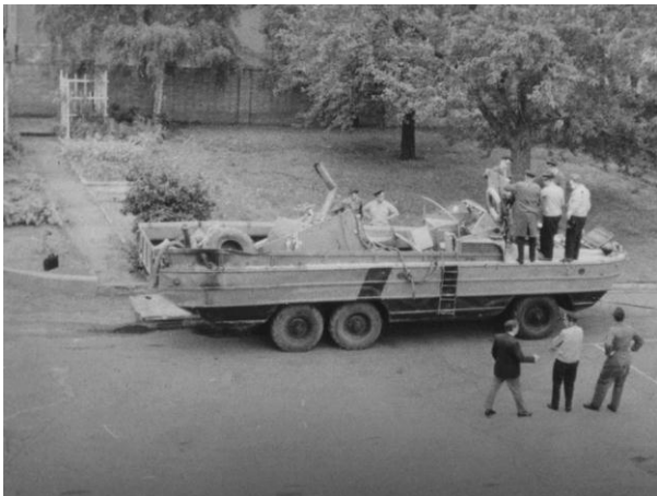
Schadensaufnahme im Jahr 1973
